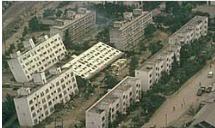
新潟地震 1964 のアパートの倒壊現象
