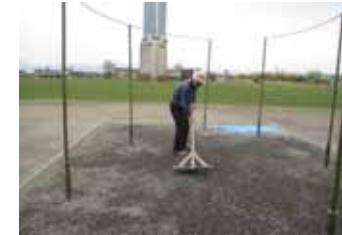
現地制作 骨組みと地表面
