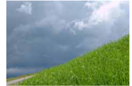
堤防と空 (小矢部川) 風景の「切れと続き」
