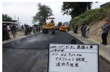
アスファルト舗装
