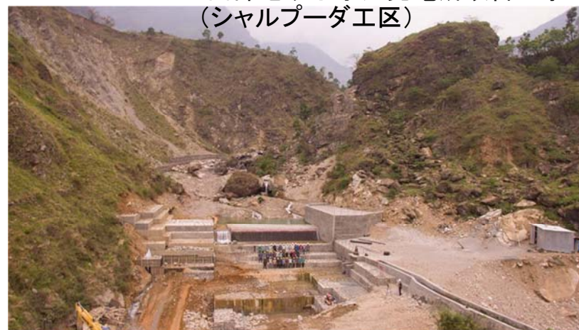
取水施設全景
