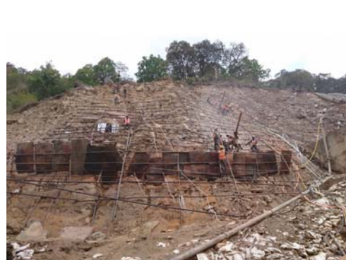
左岸側施工状況
