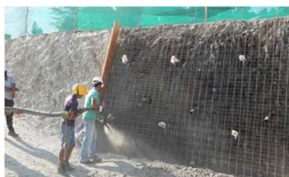
コンクリート吹付け
