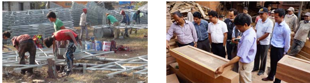
骨組み材製作
