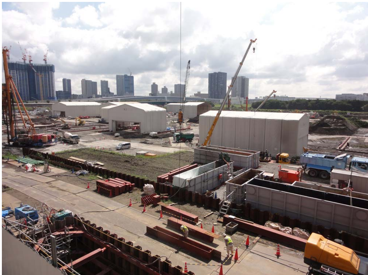
豊洲の土壌汚染対策工事
