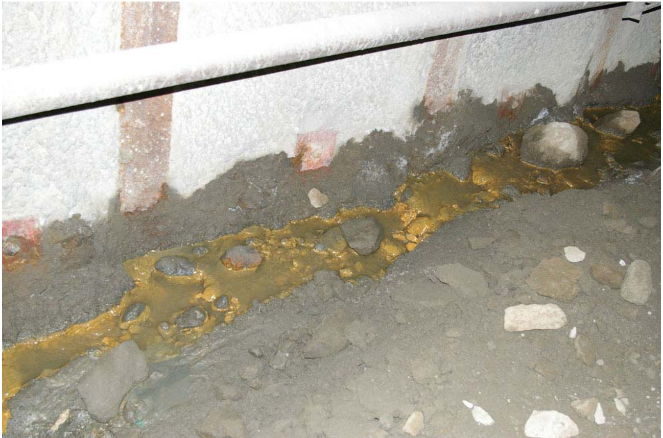
仙台市の地下鉄東西線工事現場
