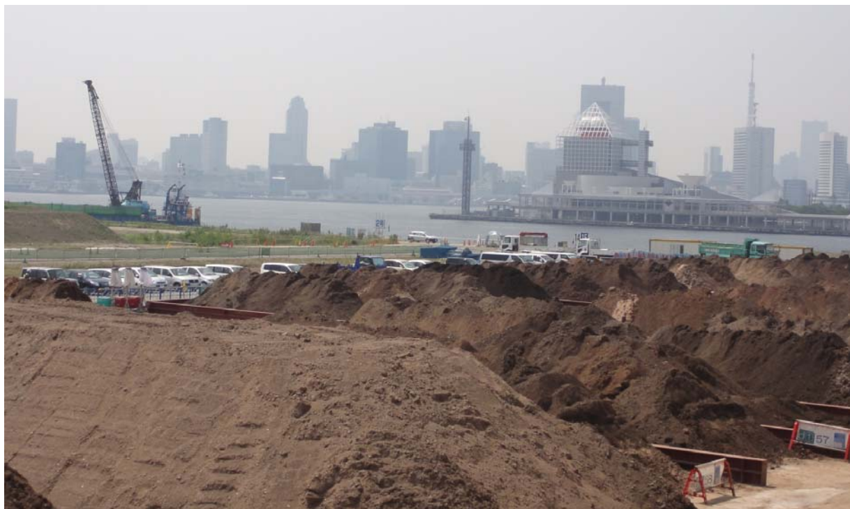
掘削除去される汚染土壌
