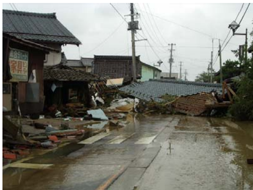
中之島町(現長岡市)内の被害
