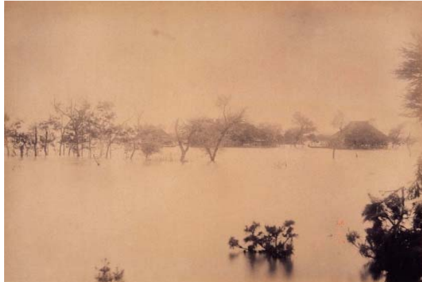
堤防が決壊してから21日後の写真(新潟市西区新通)
