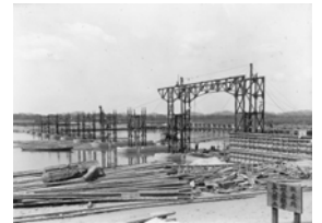
上部工鋼構脚組み立て
