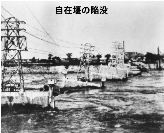
1927(昭和2)年6月24日突如として陥没した自在堰 63
