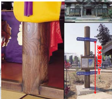
新潟市西区横尾「宝光院」に残る横田切れ痕跡（地上から2.4mの高さまで浸水）
