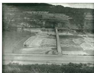
竣工(水叩き部に掛かるのは野積橋)
