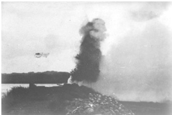
大正11(1922)年8月25日 仮締切を発破して通水 61
