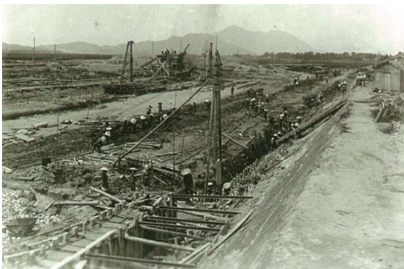
自在堰 基礎杭打ち込み
