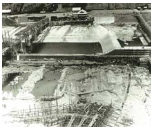
左半分を締め切り施工中
