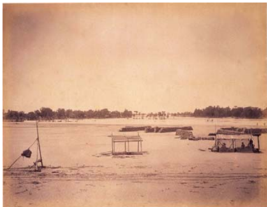
堤防が決壊してから21日後の写真(旧分水町横田)
