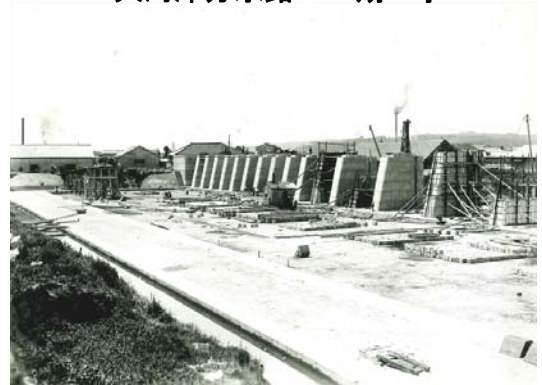
コンクリートによる洗堰の建設 遠隔操作としては日本初の近代的堰
