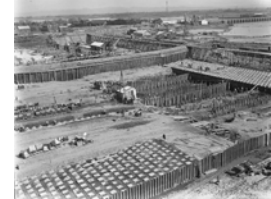
旧可動堰～第一床固 基礎
