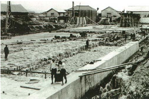
洗堰 基礎打設
