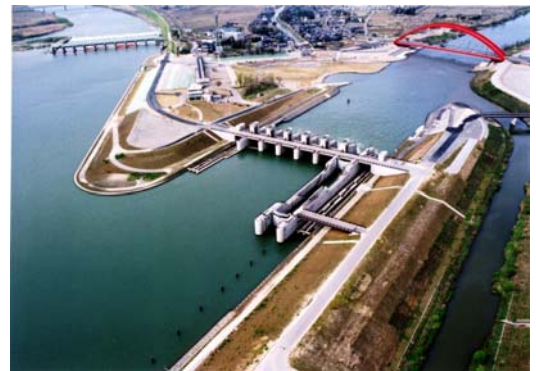
新洗堰（平成13年完成）
