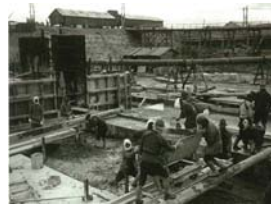
旧可動堰 基礎・堰柱 コンクリート打設
