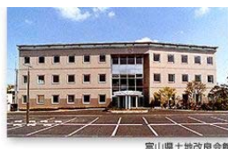
富山県土地改良会館
